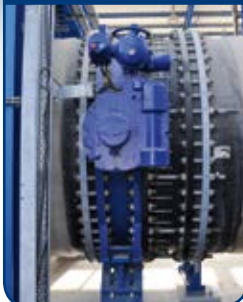
Fujairah (EE. AA. UU.) Carrete de Desmontaje
