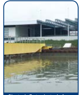
Planta de Tratamiento de Aguas Residuales, Lyon (Francia), Gran Diámetro
