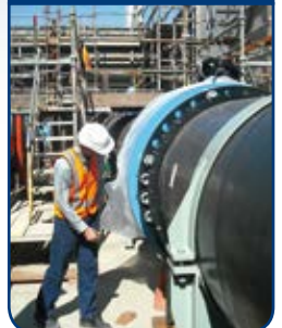
Planta desaladora (Australia), Gran Diámetro
