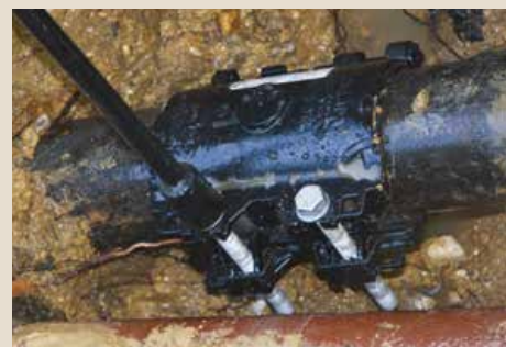
Lors du serrage des boulons, les colliers se déforment pour épouser la forme du tuyau.
