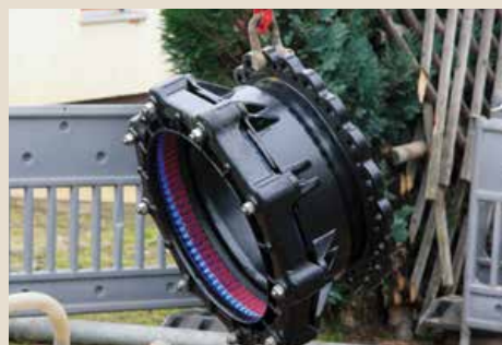
Être hissé dans la tranchée
